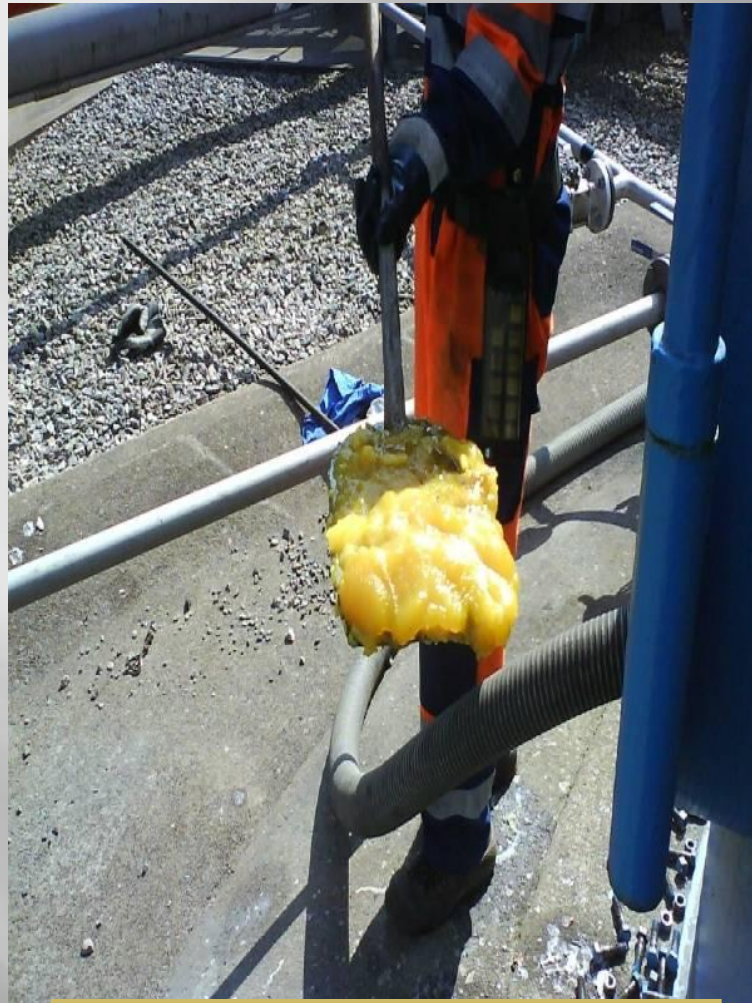
Depositi nei tank stoccaggio
