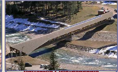
Passerella Ciclo-pedonare sull'Aviso
