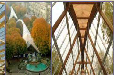
Padiglioni Atrium Torino
